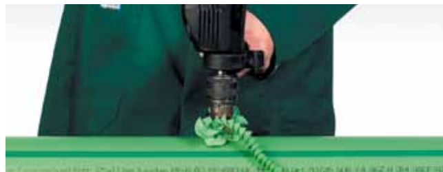
Perforar el tubo
