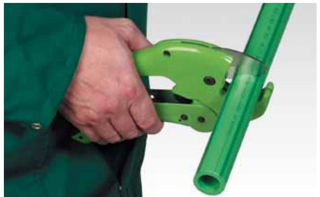
Cortar la tubería
