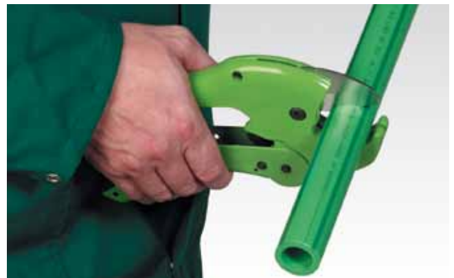
Abschneiden des Rohres
