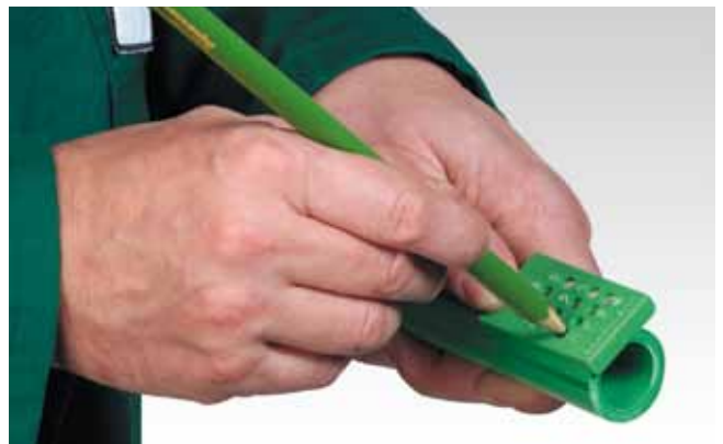
Marcar la profundidad de soldadura
