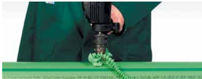
Foratura della parete del tubo.
