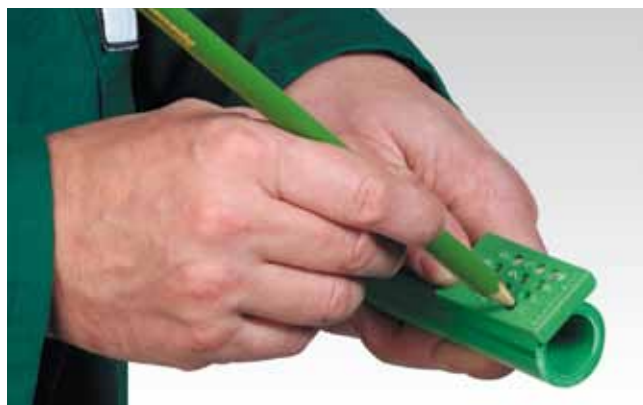
Segno della profondità di fusione.
