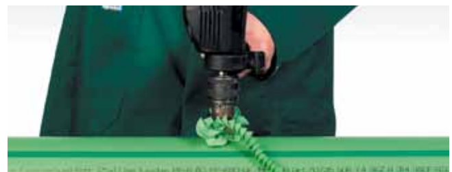
Durchbohren der Rohrwandung
