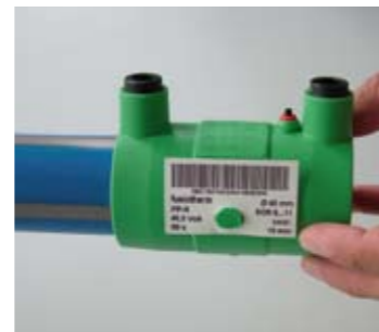
E-Muffe aufschieben
