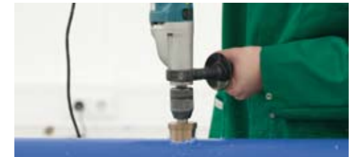
Durchbohren der Rohrwandung
