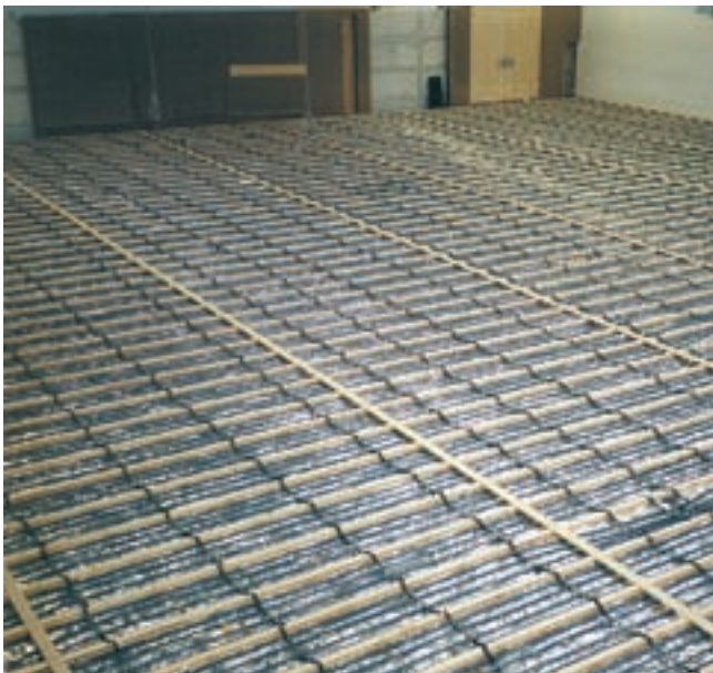
Verlegetechnik mit Rohrführungsschiene
