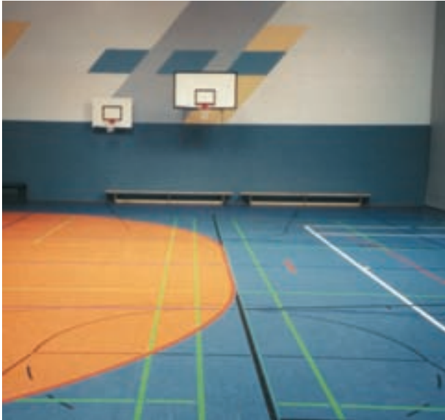
Fertig verlegte Sporthalle mit aquatherm®-Sportbodenheizung und Linoleum-Oberbelag
