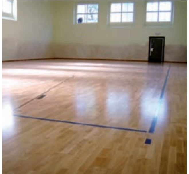
Fertig verlegte Sporthalle mit aquatherm®-Sportbodenheizung und Parkett
