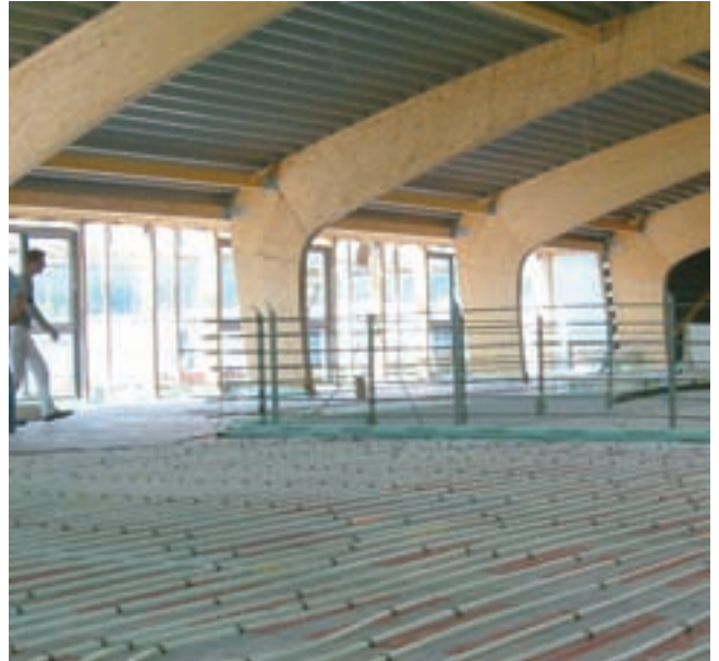
MAX-FITNESS-CENTER, Verlegung der Sportbodenheizung
