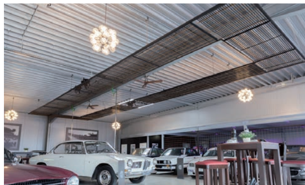
Im Verkaufsbereich des Depot3 wurden die aquatherm black system Register auf einen von der Hallendecke abgehängten Stahlrahmen montiert.
