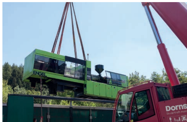
Mit einem Kran wurden die Maschinen verladen.
