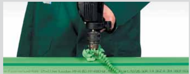
Durchbohren der Rohrwandung
